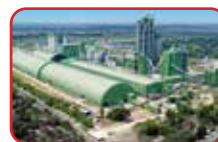
Kompleks Pabrik Grobogan, Jawa Tengah Grobogan Factory, Central Java
