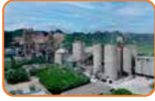
Kompleks Pabrik Maros, Sulawesi Selatan Maros Factory, South Sulawesi
